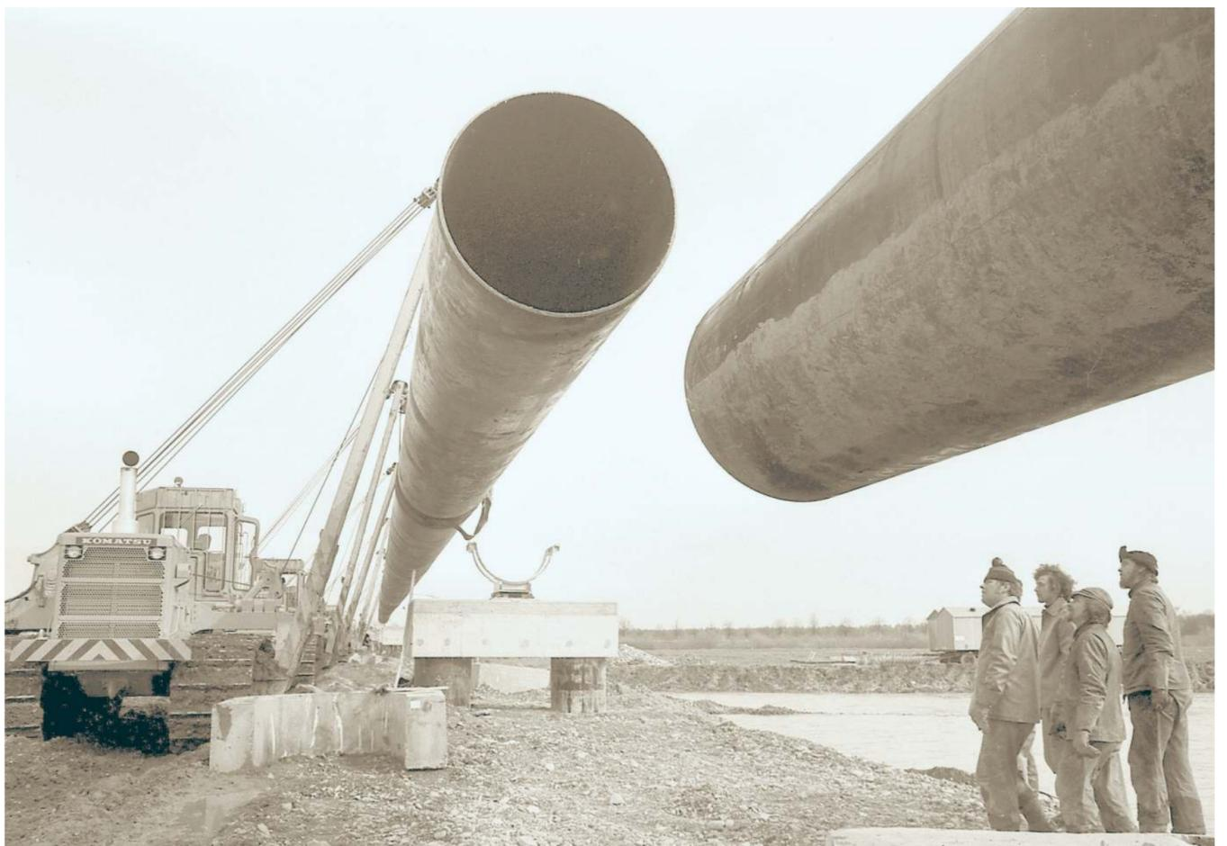
Gewaltige Dimensionen: Die Rohre der Erdgasstrasse maßen 1,42 Meter im Durchmesser. Einzeln verschweißt mussten die Nähte im Anschluss nachgeschliffen werden. FOTO: DPA
